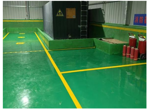
废矿物油贮存库
